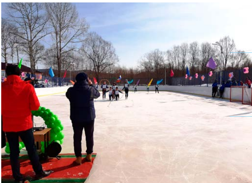
Установка хоккейного корта, СОШ с. Первомайск
