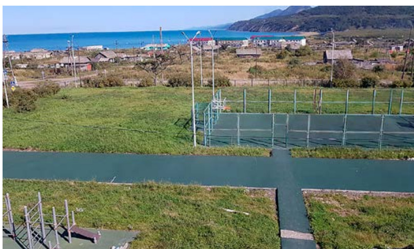
Обустройство беговой дорожки на школьном стадионе СОШ с. Лесогорское
