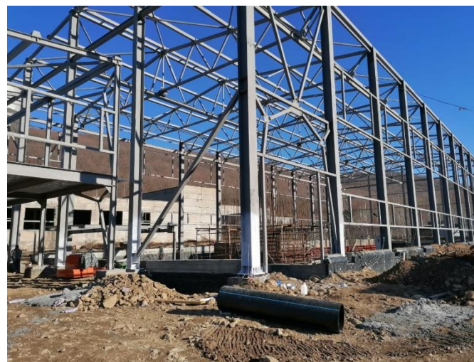
Арсеньев. Водоочистные сооружения на р. Дачная
