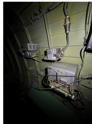
приборы после ремонта в хвостовой части самолета
