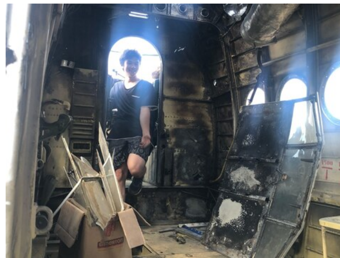
Приборка и подготовка кабины
