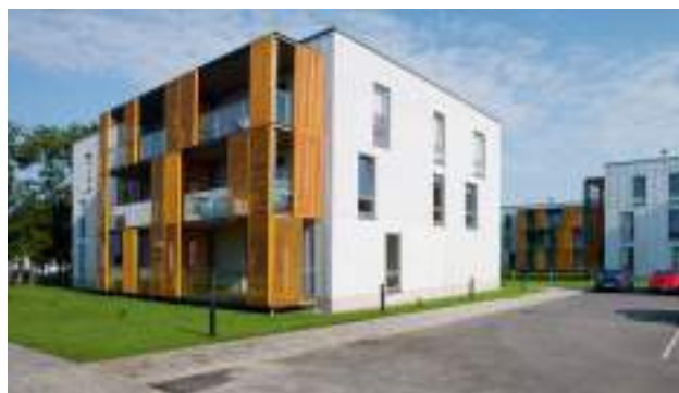
Таллин, Эстония © JVR Arhitektuuribüroo
